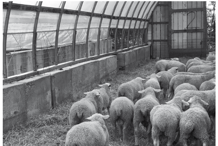
Agnelles et bâtiment serre : sept serres servent à abriter le troupeau. L'été elles sont utilisées pour l'élevage des sujets reproducteurs.
