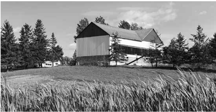
Une vue extérieure du parc d'engraissement, remarquez les ouvertures pour la ventilation naturelle.
